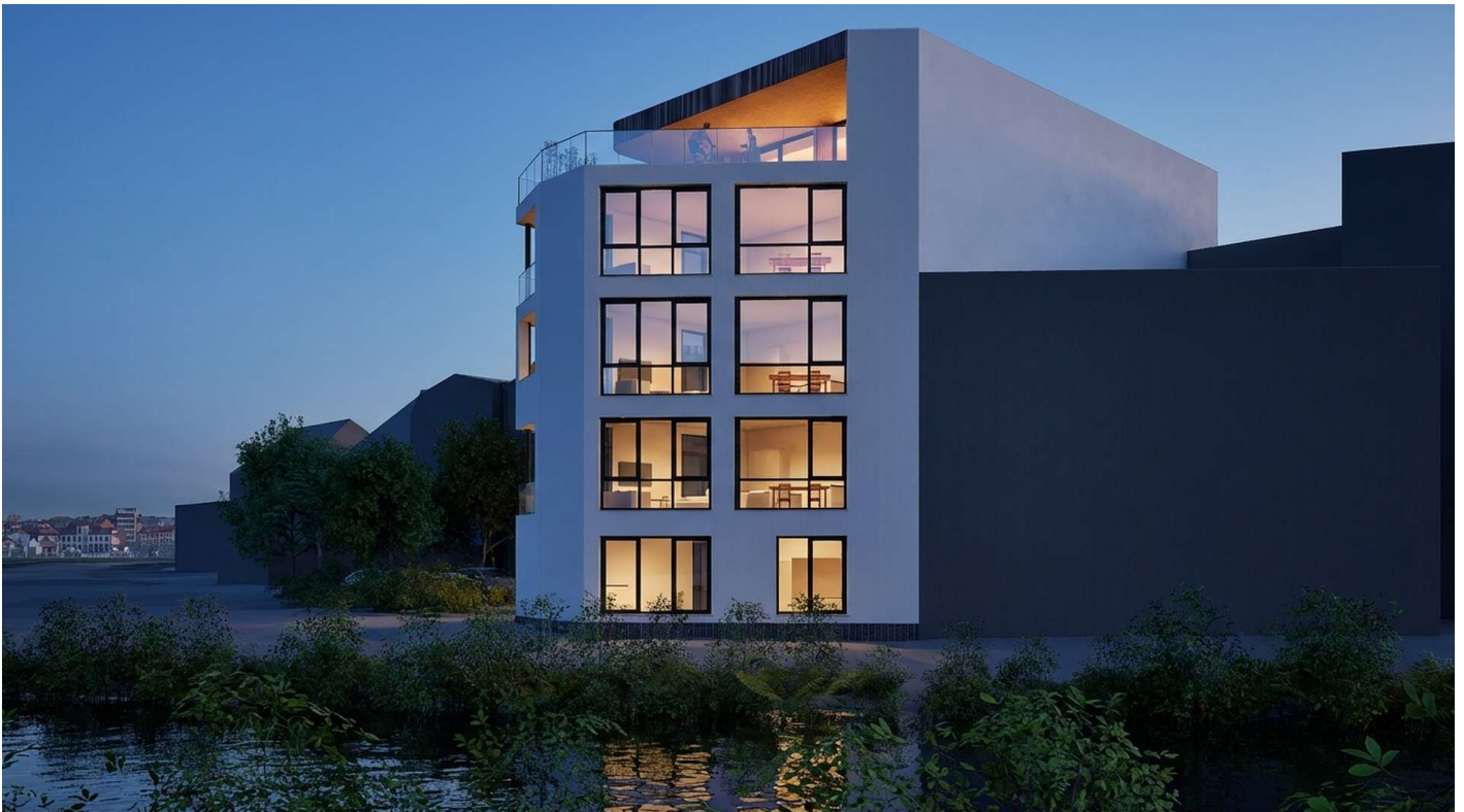
Visu seitlich von Ruhrbrücke
